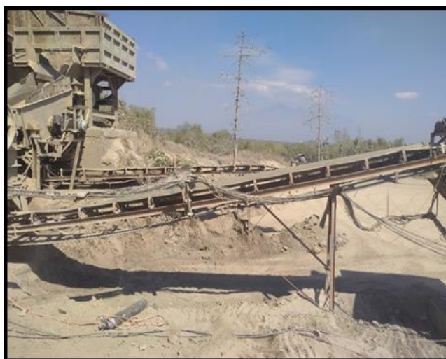
Gambar 3. Belt conveyor di lapangan
