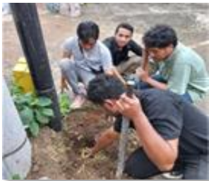
Gambar 7. Penggalian tanah untuk pondasi tiang bunga
