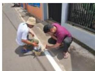
Gambar 12. Pengecatan marka jalan
