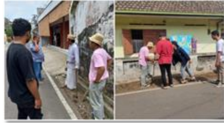
Gambar 6. Penentuan titik lokasi pemasangan tiang
