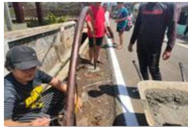
Gambar 8. Pengecoran tiang tanaman bunga
