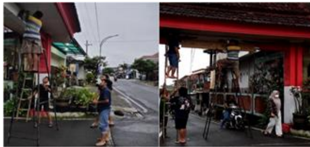
Gambar 15. Pemasangan papan nama gapura
