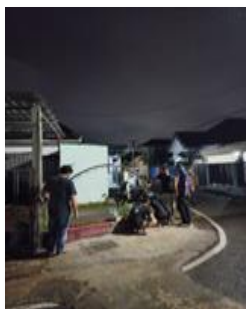
Gambar 10. Pemasangan tiang dengan cara di clamp
