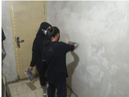
Gambar 7. Pengaplikasian Plamir pada Dinding
