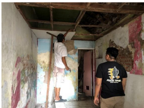
Gambar 4. Pemasangan plafon
