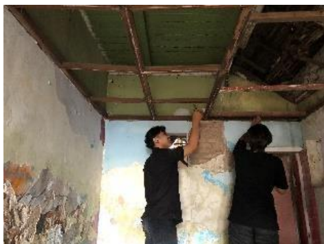
Gambar 1. Tahap pembongkaran plafon
