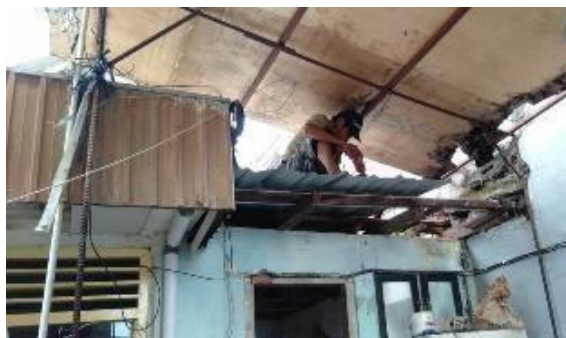
Gambar 3. Pemasangan atap Zincalume
