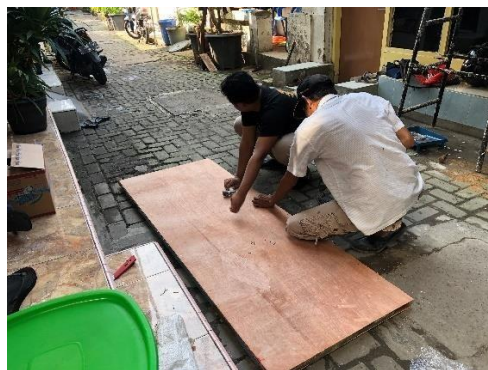
Gambar 5. perbaikan daun pintu
