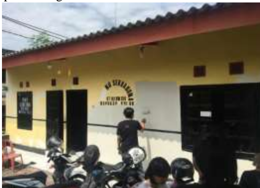
Gambar 6. Kondisi Eksisting Balai RT
