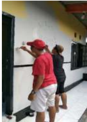
Gambar 7. Perbaikan Balai RT dengan Pengecatan Ulang Dinding
