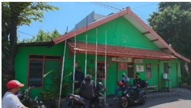
Gambar 1. Kondisi Eksisting Balai RT
