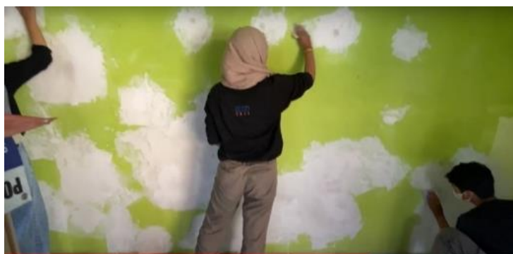
Gambar 2. Kondisi Dinding Bagian dalam Balai RT
