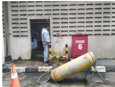
Gambar 10 Proses penambahan gas ammonia (NH 3 ) Sumber : Dokumentasi Pribadi
