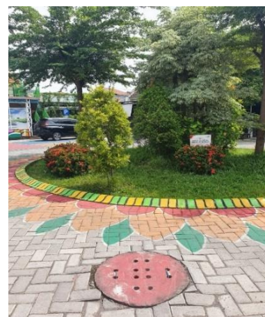
Gambar 7. Sumur Resapan di Sekitar Area Fasilitas Umum
