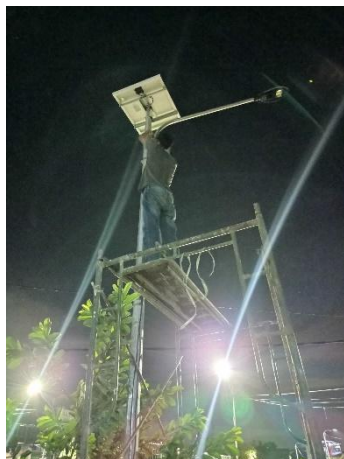
Gambar 3. Pemasangan dan Uji Coba Penerangan Bertenaga Surya
