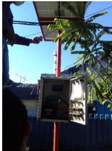
Gambar 11. Hasil Instalasi Sistem Panel Surya
