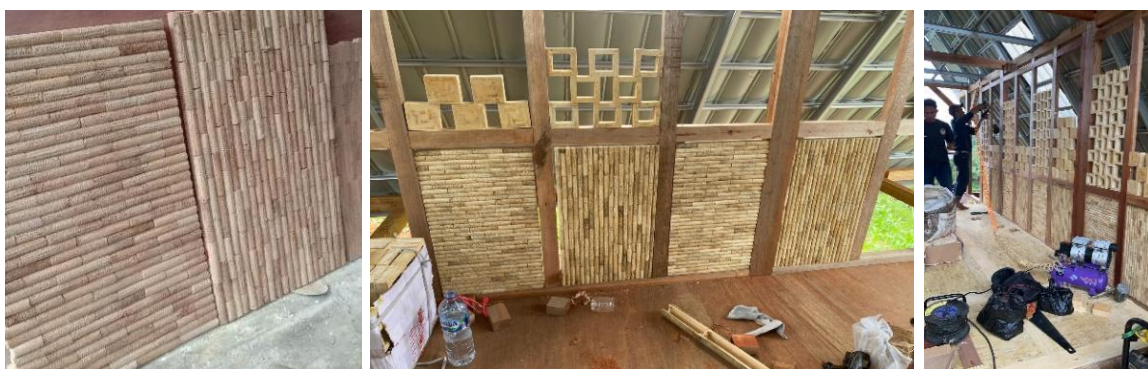
Gambar 10. Variasi dinding berbahan bonggol jagung (Sumber: Dok. Kedaireka Itenas, 2021)
