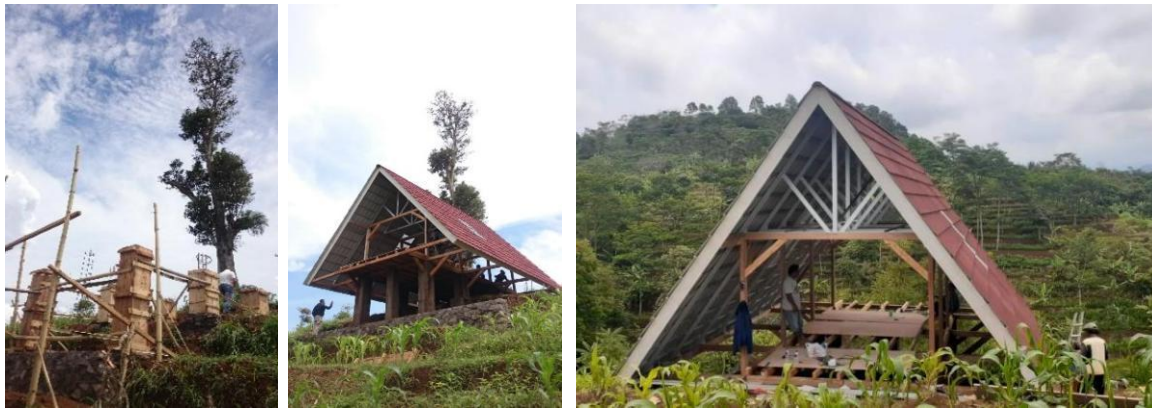
Gambar 7. Tahap pembangunan Rumah Bonggol Jagung di Pasir Salam dengan latar belakang pohon Salam yang telah berusia ratusan tahun (Sumber: Dok. Kedaireka Itenas, 2021)
