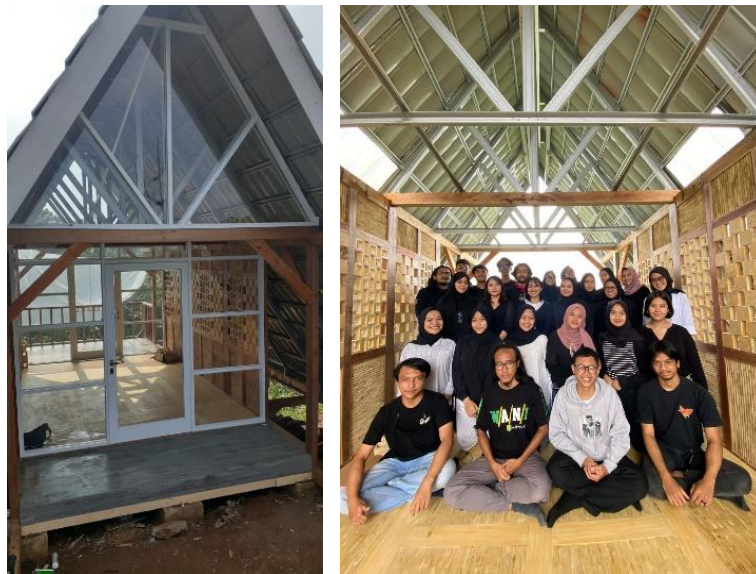
Gambar 12. Kondisi terakhir Rumah Bonggol Jagung yang telah selesai dibangun (kiri) dan dokumentasi mahasiswa Itenas peserta kegiatan PkM (Sumber: Dok. Kedaireka Itenas, 2021)
