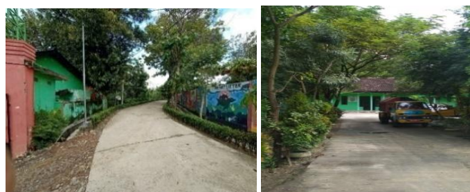
Gambar 2. Jalan Masuk dan Jalan Operasional di TPA Selopuro
