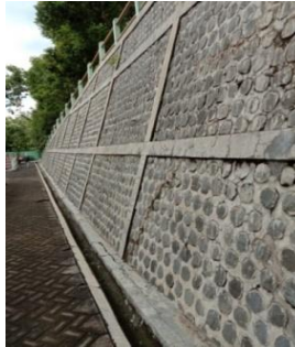
Gambar 3. Drainase di TPA Selopuro
