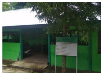
Gambar 14. Rumah Pengomposan di TPA Selopuro
