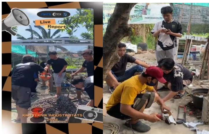
Gambar 6. Dokumentasi pelaksanaan pembangunan greenhouse .
