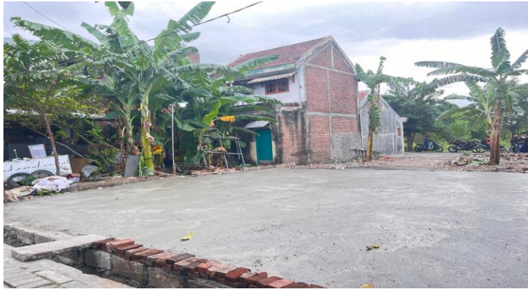
Gambar 11. Hasil akhir tempat fasilitas umum di RT 07, Kelurahan Kandangan.
